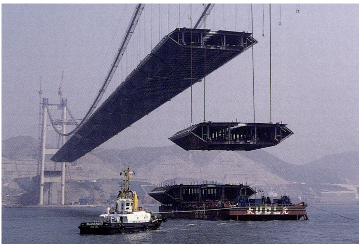
吊裝重 1000 噸的橋
